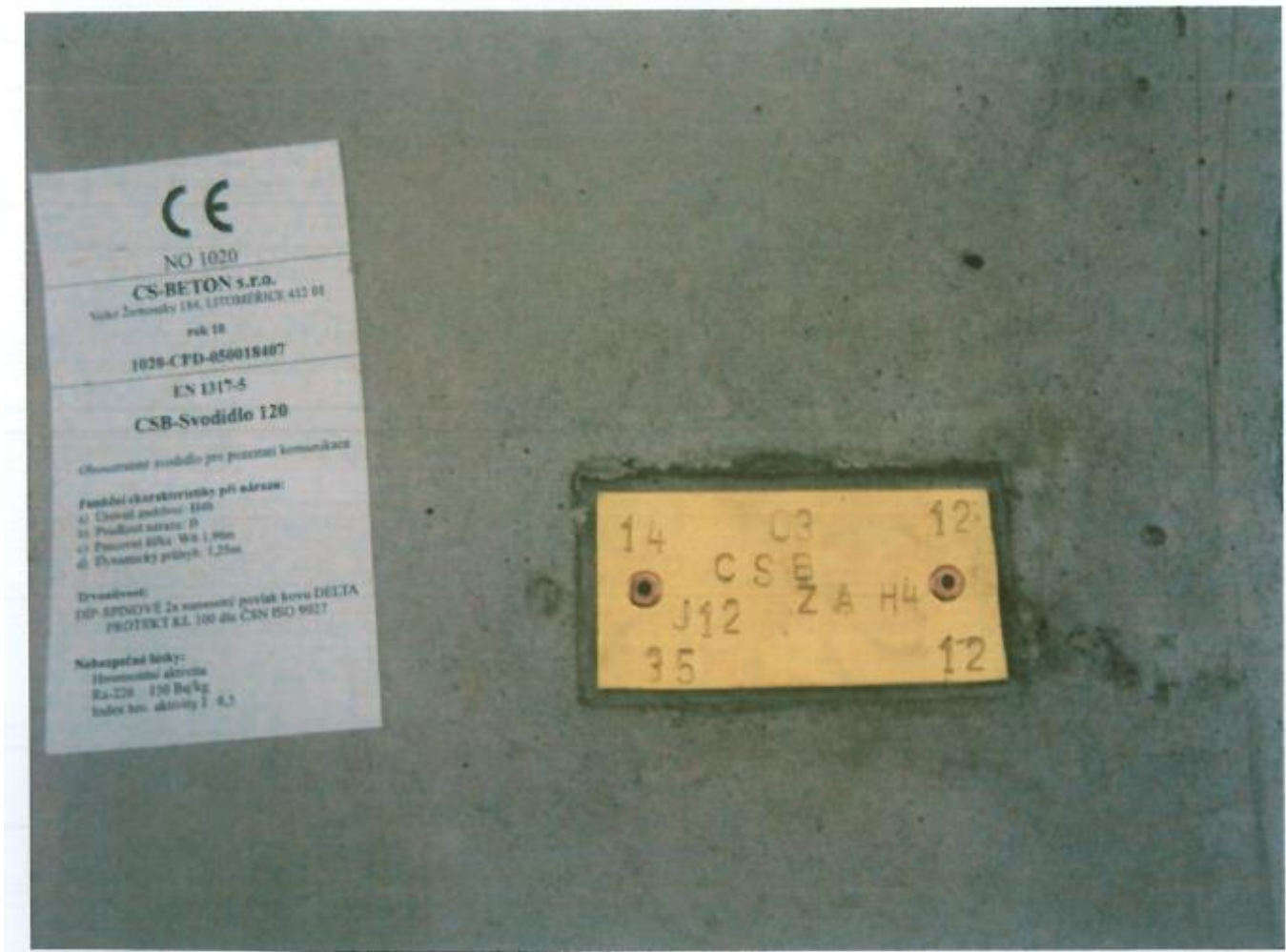
Abbildung 12 – CE-Etikett und Messingetikett zur Kennzeichnung von Betonleitplanken CS BETON
