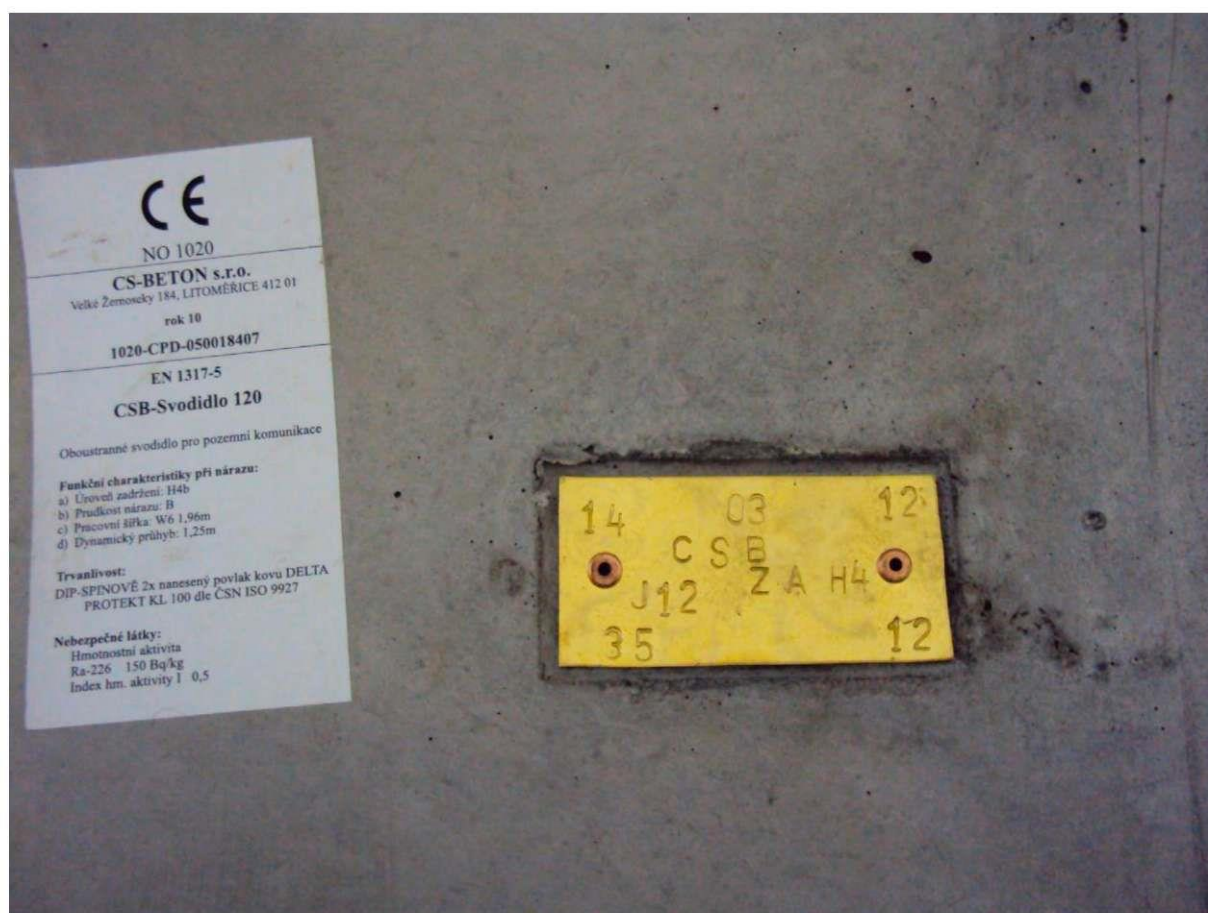
Rysunek 12 – Etykieta CE i tabliczka mosiężna oznakowania barier betonowych CS BETON
