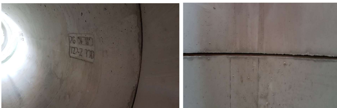
Obrázek č. 6 – Detail vnitřní spáry po spojení trub
